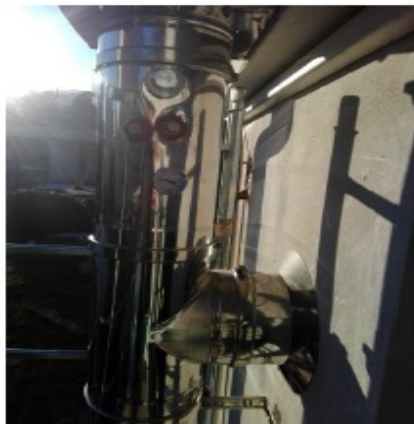
Figura 2: particolare del punto di campionamento
